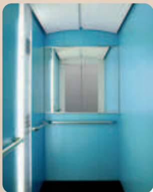
Двухслойная облицовочная панель: слой поливинилхлорида на гальванизированной листовой стали
